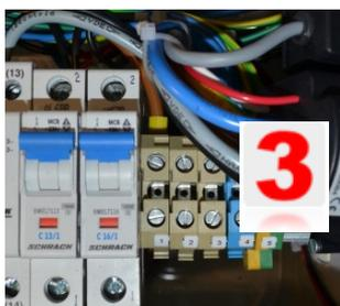
5. Zugentlastung und Anschluss 3 durch Elektrotechniker
