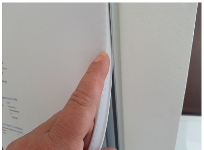
#8 Einsetzen des Spanntuches mit Gummilippe
